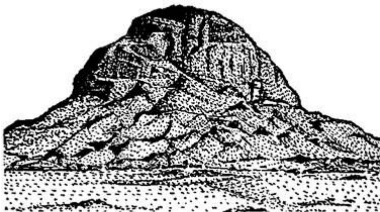
Рис. 6. Разрушенная пирамида Сенусерта I в Лакхуне. Центральная часть — обнаженная скальная порода, поверх которой была сделана надстройка из глиняных кирпичей высотой около 160 футов, укреплена каменными стенами и внешней кладкой из известняка, позднее снятой рабочими Рамсеса II. Под мусором на высоте одного фута был обнаружен вход и гробница дочери фараона, Ситхаторюнет (фото 27). Приблизительно 1880 г. до н. э.
